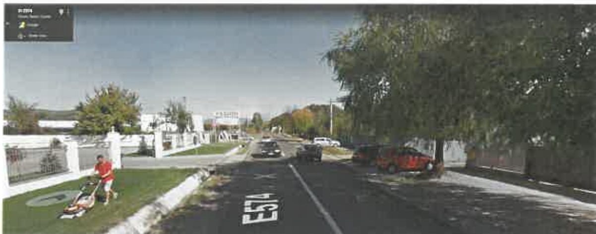
Calea Brașovului (DN11/E574) - în stânga imaginii este vizibil accesul la amplasament și fâșia verde ce poate fi utilizată parțial pentru amenajarea trotuarului Sursa: Google Street View
