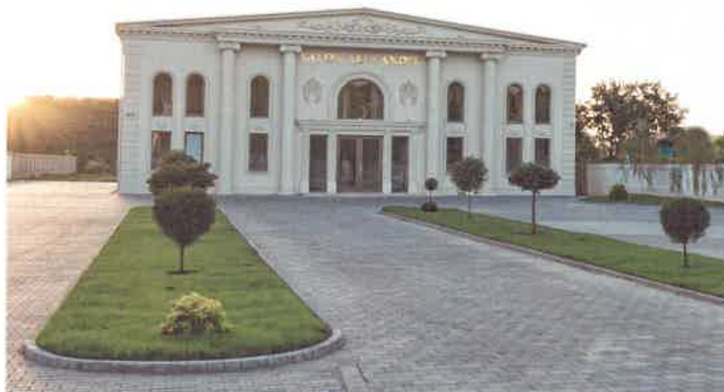
Sală de evenimente existentă, edificată în baza Autorizației de construire nr. 11/2017 eliberată de Primăria municipiului Onești Sursa: pagina web salonalexander.ro
