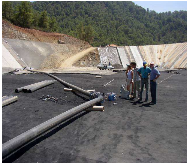
Figura 5.2-7: Construcția unui depozit
